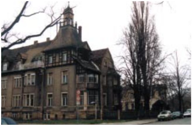
Die Wohnung mit dem duftenden Wintergarten, Hübnerstraße 12, Erdgeschoss
